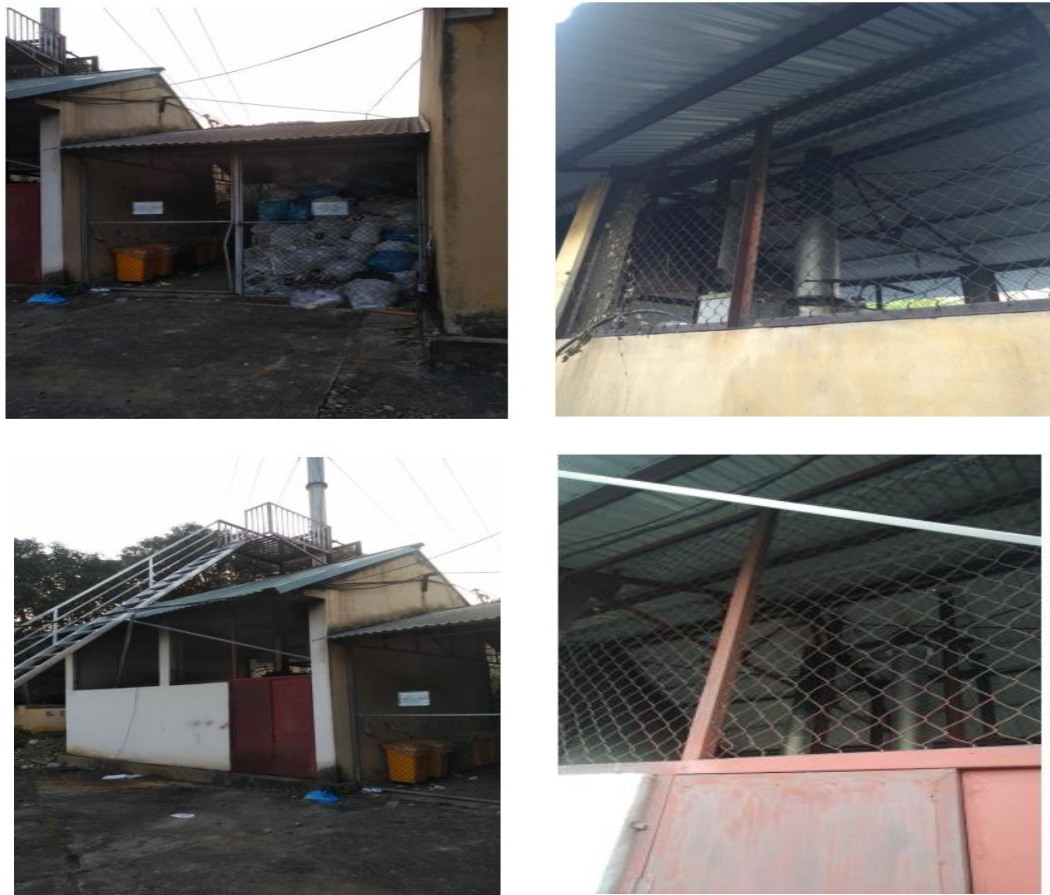
Hình 1.14. Một số hình ảnh về khu xử lý chất thải Trung tâm y tế Bảo Lạc
